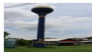
ถังเก็บน้ำ หอส่งน้ำ (ประปา รร.) ปีที่สร้าง ๒๕๖๑
