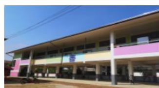
อาคารเรียน สปช. ๑๐๕/๒๙ ปีที่สร้าง ๒๕๖๒
