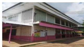
อาคารเรียน สปช.๑๐๑/๒๖ ปีที่สร้าง ๒๕๒๕
