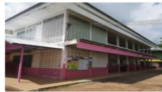
อาคารเรียน สปช.101/26 ปีที่สร้าง 2525
