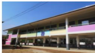
อาคารเรียน สปช. 105/29 2 ชั้น 4 ห้อง ใต้ถุนโล่ง ปีที่สร้าง 2562
